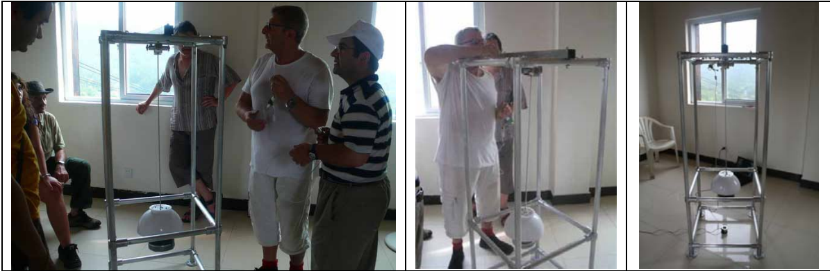
Fotos 16, 17 y 18. Instalación del globo, del microsismómetro y de la cámara web. (Foto 16 de Dolores Iglesias y fotos 17 y 18 de Florencio Málaga)
