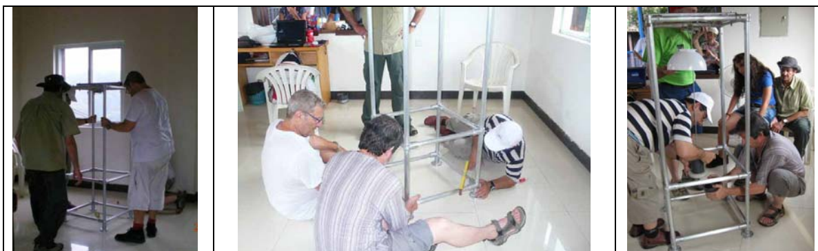
Fotos 13, 14 y 15. Traslado y nivelación del bastidor e instalación del cestillo. (Fotos de Mercedes Pino, Dolores Iglesias y Santiago de la Flor, respectivamente).
